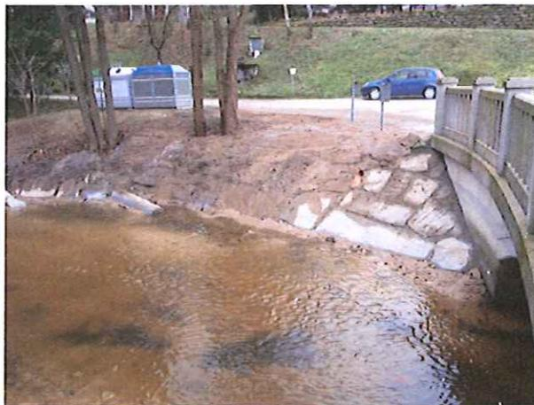
In Griesbach wurden die Böschungen des Kastanitzerbachs im Bereich der Kläranlage und im Bereich der Brücke beim Vereinshaus neu angelegt. Diese Arbeiten wurden vom Braunau-Reissbach-Wasserverband durchgeführt.
